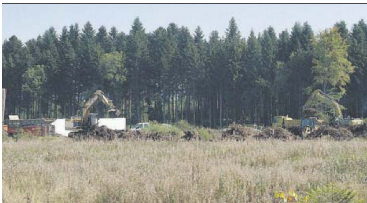
Während auf der gegenüberliegenden Straßenseite die Bauarbeiten bei Straßenbau Walter schon sehr weit vorangekommen sind, wurde beim Großprojekt der Maschinenfabrik Spaichingen jetzt mit den ersten Erdbewegungen begonnen. Foto: Ingrid Kohler
