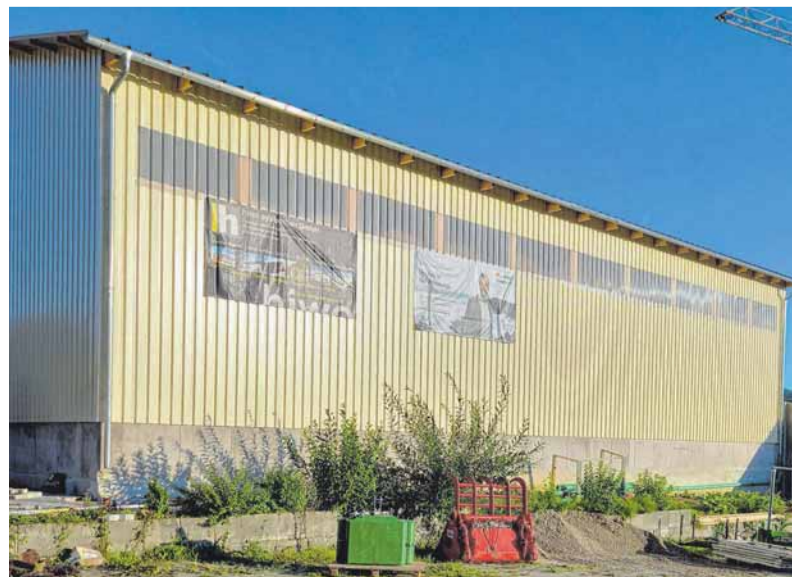
Im Pferdeparadies Haug geht es voran. Der Talheimer Reiterhof hat nach dem Brand im April eine neue Halle erstellt.
